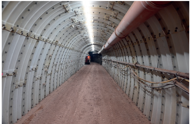
Fig. 14. Looking into the bypass from the Christopher shaft Bild 14. Blick in die Umfahrung vom Christopherschacht aus. Photo/Foto: G.U.B. Ingenieur AG
