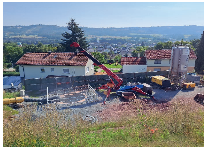
Fig. 9. Construction site equipment and shaft mouth. Bild 9. Baustelleneinrichtung und Schachtmundloch. Photo/Foto: Bergamt Nordbayern
