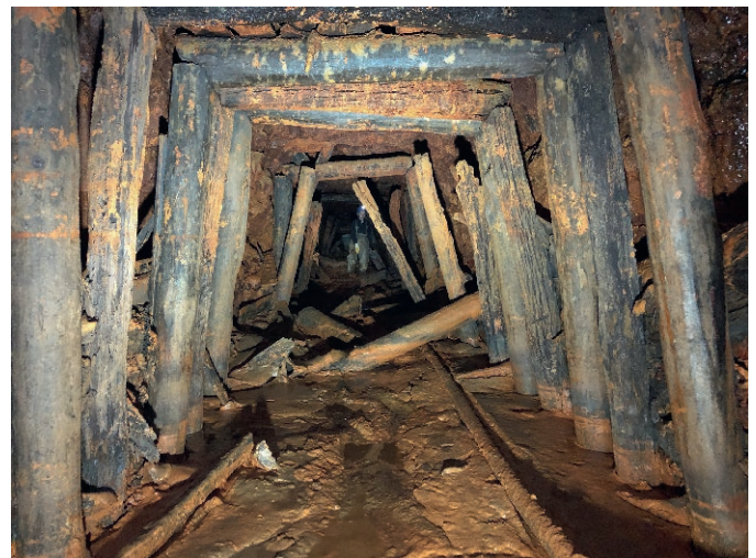
Fig. 12. K. B. Maximilian heritage gallery with collapsed frame-type timber supports lying in sediment, view looking to the south east. Bild 12. K. B. Maximilian Erbstollen, alter verbrochener Türstockausbau im Sediment, Blick nach Südosten. Photo/Foto: G.U.B. Ingenieur AG
