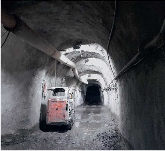
Fig. 15. Looking into the bypass from the St. Katharina hoisting shaft. // Bild 15. Blick in die Umfahrung vom St. Katharina Förderschacht aus. Photo/Foto: G.U.B. Ingenieur AG
