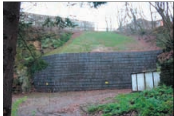
Böschung nach der Sicherung
