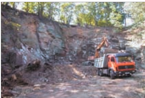
Böschung während Beräumung
