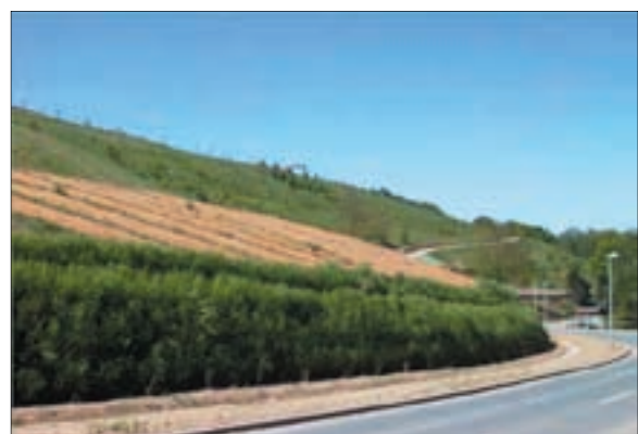
Haldenfuß nach der Sanierung
