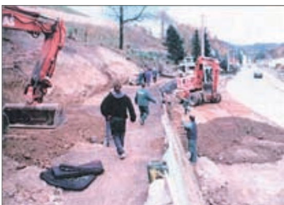
Haldenfuß während der Bauphase
